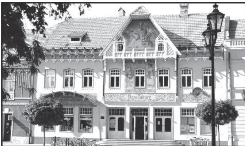
(1) Súčasný Dom kultúry realizovaný podľa projektu architekta Dušana Jurkoviča
